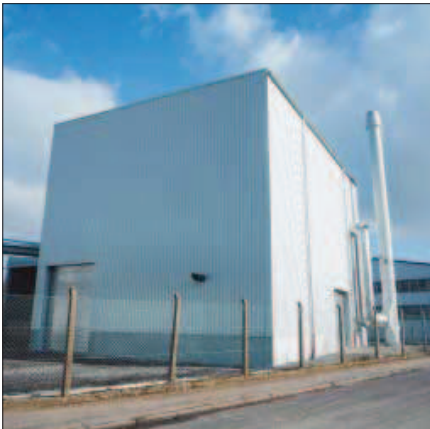
Das Maschinenhaus der neuen Energiewerks in Laubach.
