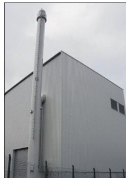
Außensicht des Heizwerks.
